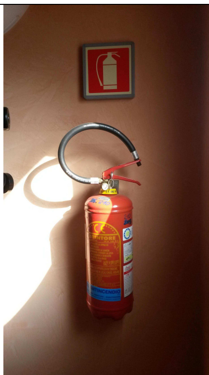
Vano disimpegno primo piano
