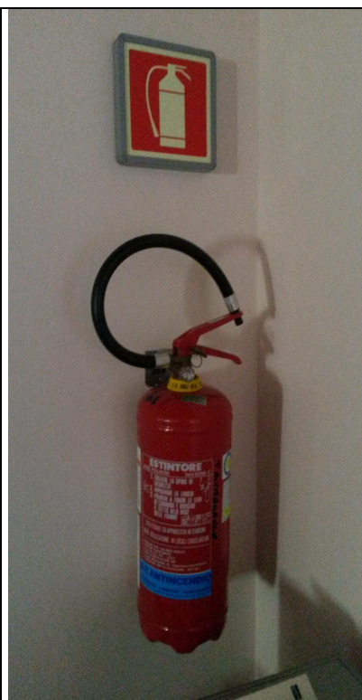
Sala grande piano primo
